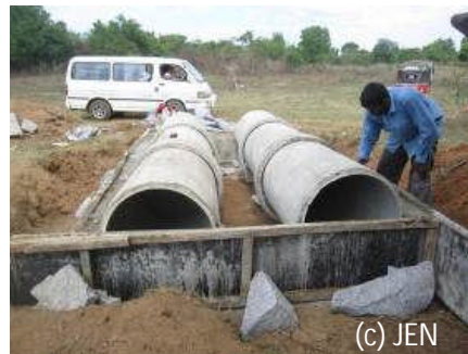
排水溝再建中の様子
